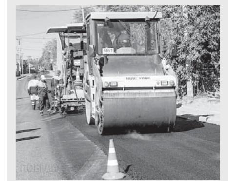
При проведении обследования данного участка было выявлено множество дефектов — колебательность, сетка трещин, разрушение кромок покрытия проезжей части, просадки, а местами и обрывы. Также не соответствуют требованиям и обочины. Но все это будет устранено при проведении ремонта.
