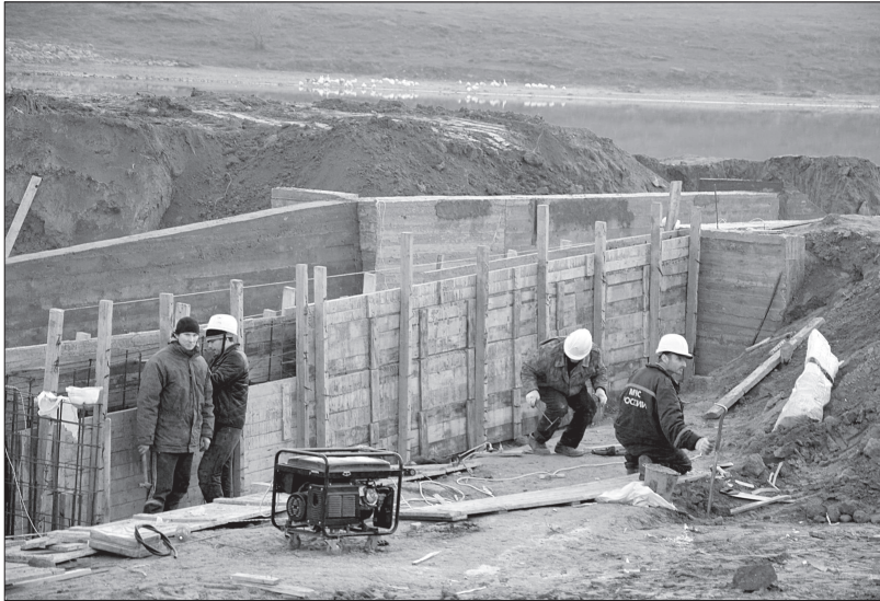
Работы по расчистке русла Мокрой Буйволы в Благодарненском городском округе завершатся до конца года. Расчистка русла реки ведется на участке протяженностью 3,67 километра.
