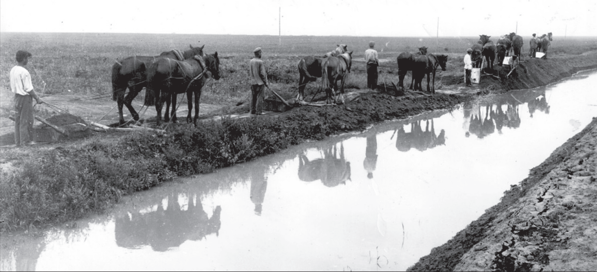
• Ликвидация просадок насыпи на каналах системы ползунковыми конными скреперами, 1930-е годы.
