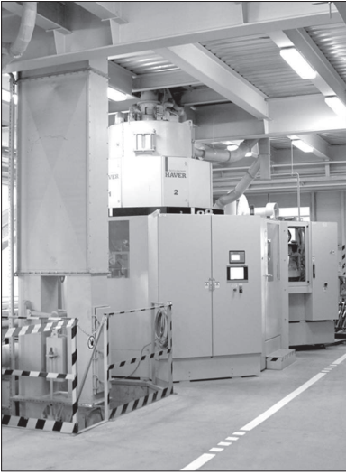
• Завод «Хенкель-Баутехник» в Кочубеевском районе производит около 130 тысяч тонн строительных смесей в год.
