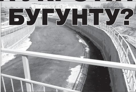
• Часть реки Бугунты уже заключена в такой железобетонный лоток.
