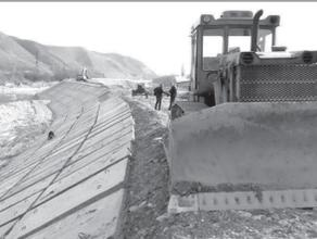
• На реке Подкумок заканчивают укреплять дамбу железобетонными плитами.
