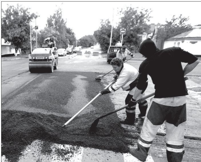
● Ремонт дорожного полотна на улице 8 Марта в Ставрополе.
