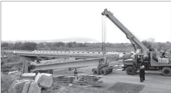
● Строительство моста через реку Подкумок.
