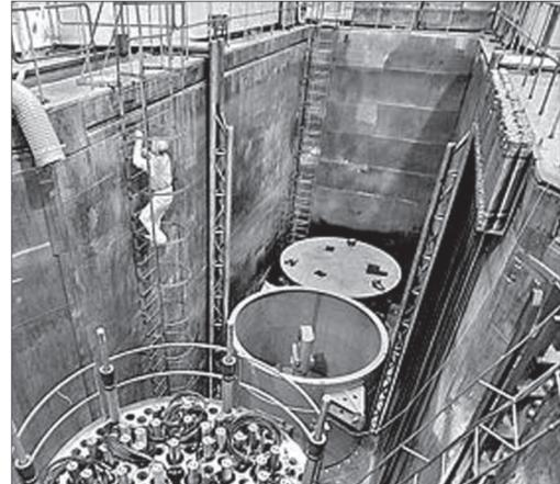
● Вот так выглядит реакторное отделение атомной станции. Под крышкой - ядерная энергия мощностью в 1000 мегаватт. Во время планового ремонта сотрудники заменяют отработанные тепловыделяющие элементы на новые.
