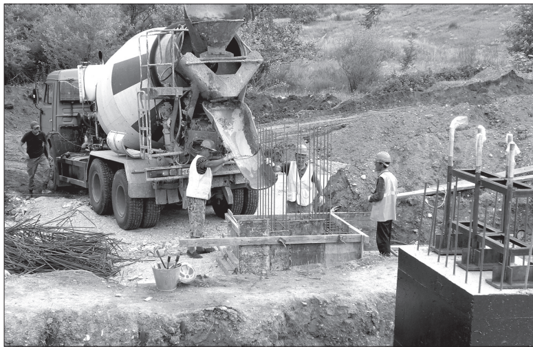
Строители заливают бетон в фундамент ФОКа.
